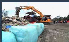
掩埋場 活化工程
